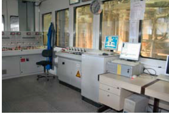
Abb. 4 Steuerungszentrale als Kapselsteuerung in einem klimatisierten Bedienraum.
