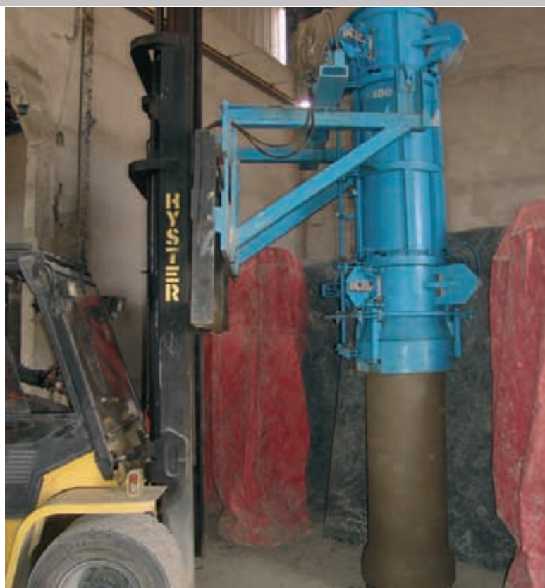
Desmoldear los tubos con carretilla elevadora
