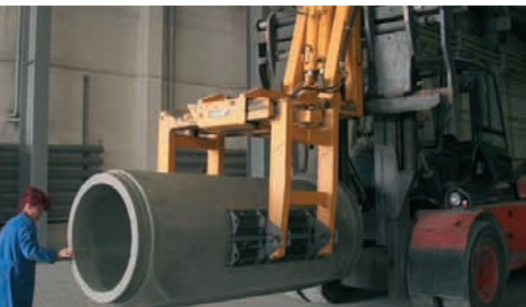
Retiro de los tubos con carrilla elevadora
