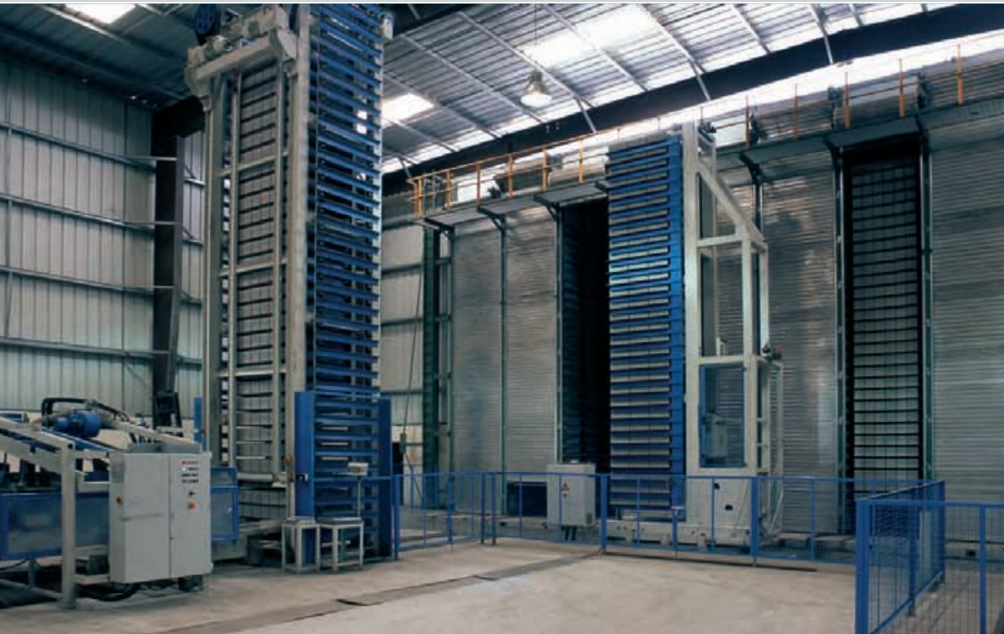
Regalanlage mit Rolltoren
